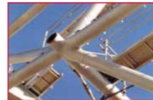
Figura 3: Nodo fuso con puntoni trasversali
