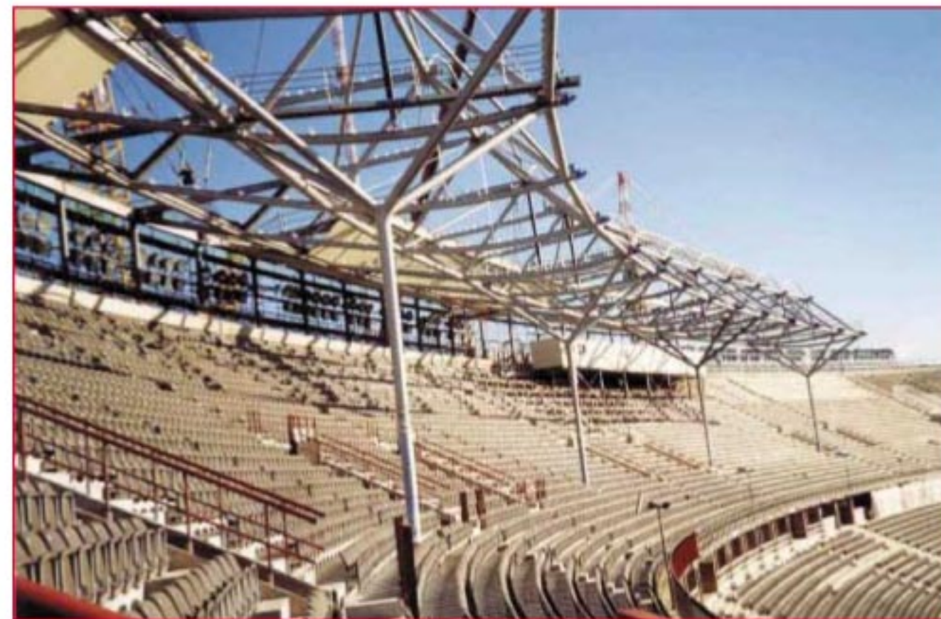
Figura 2: Fasi iniziali di costruzione della copertura. Architetti: von Gerken, Mang and Partner. Fotografia: Heiner Leiska
